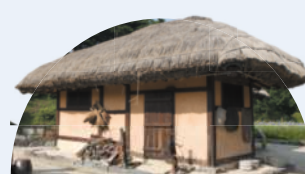
온대 기후의 초가집(한국) | 흙과 볏짚을 이용한 가옥으로, 흙벽은 단열성이 좋아 여름에는 시원하고 겨울에는 따뜻하다.
